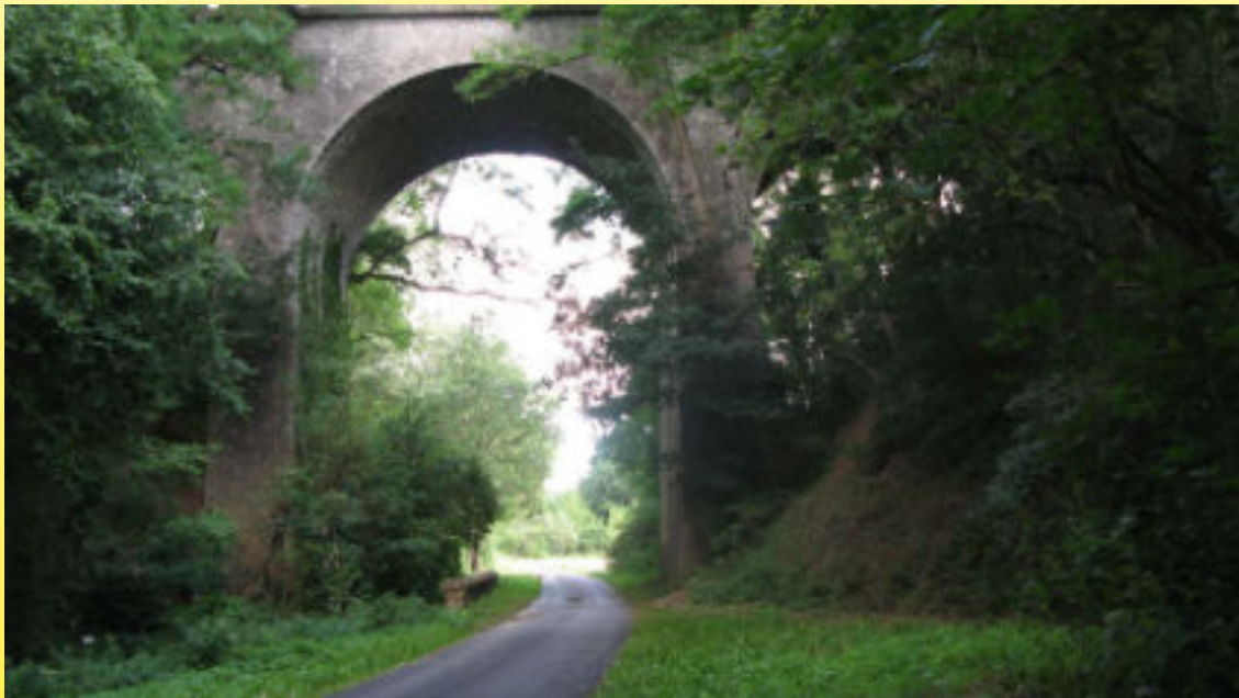
Viaduc de Gourville
